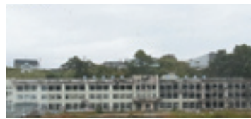
東日本大震災による津波被害で廃墟と化した校舎
