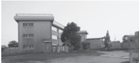
体育館が解体された白浜小学校
