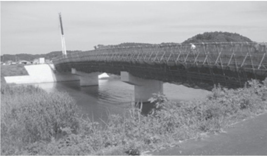
完成が待たれる新粟嶋橋
