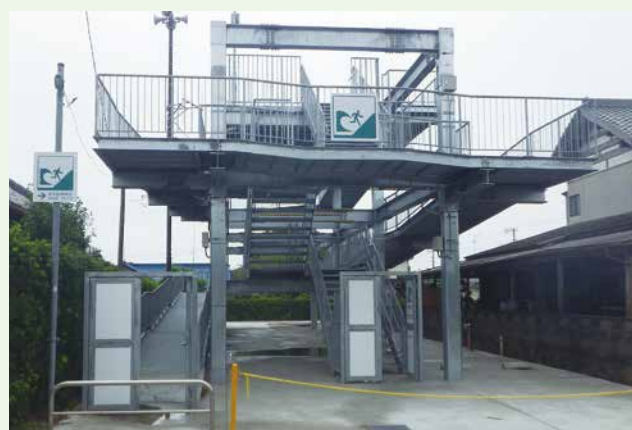
津波避難タワー
