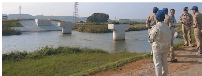
栗島橋の橋脚・橋台
