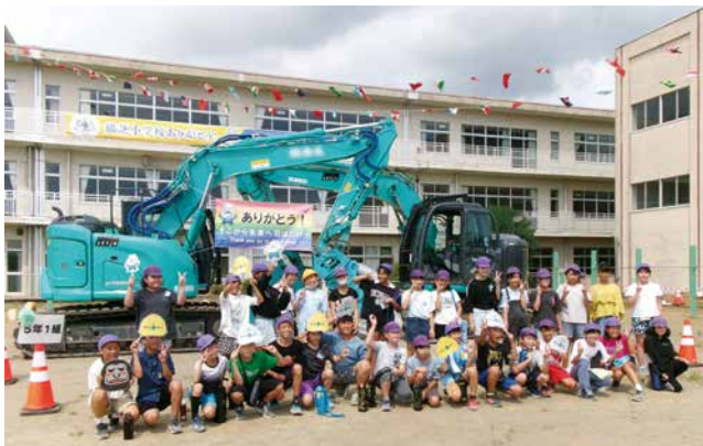
解体予定の校舎をバックに重機と記念写真～約60年間ありがとう～
