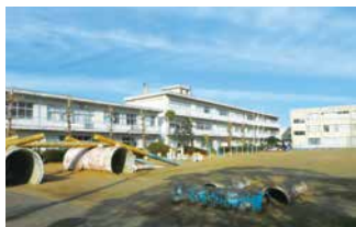
解体される横芝小学校旧校舎
