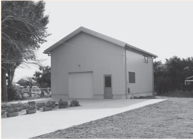
栗山中央共同利用施設「災害備蓄品倉庫」
