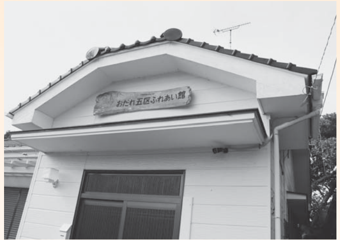
おだれ五区ふれあい館「監視カメラ」設置
