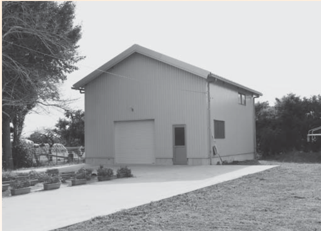
栗山中央共同利用施設「災害備蓄品倉庫」
