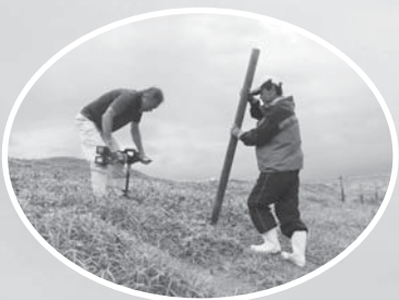
木杭を打ち直す作業をするボランティアの方々
