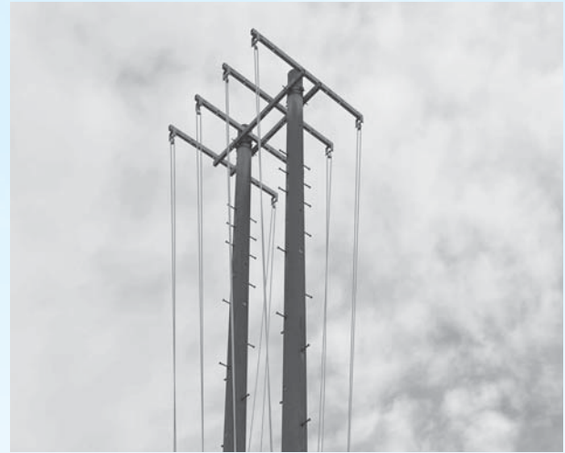
消防ホース乾燥塔 (第8分団第2部：白磯・辻・関地区)
