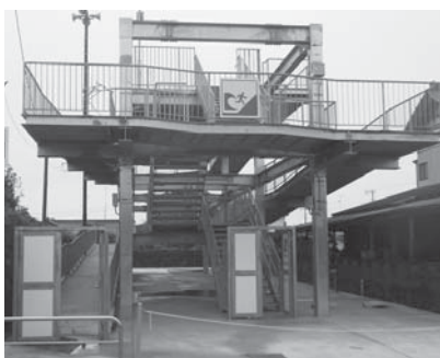
▲津波避難タワー
