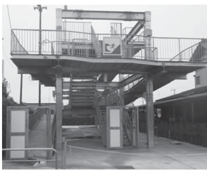
▲津波避難タワー
