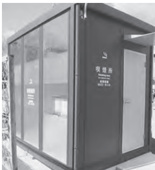
▲喫煙所（役場西側駐車場）
