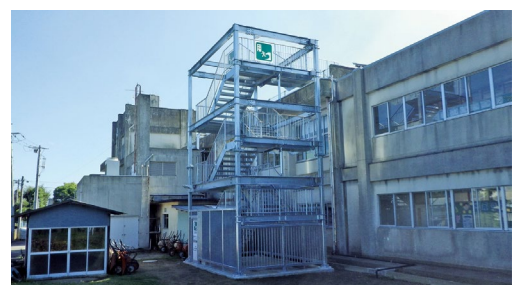
上堺小学校の津波避難用の外階段
