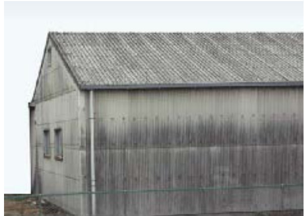
石綿含有スレート波板（屋根・外壁）
