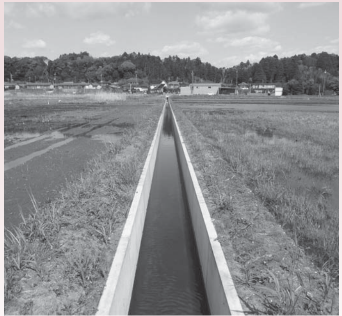
母子地先排水路整備工事
