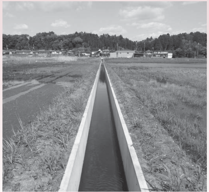
母子地先排水路整備工事
