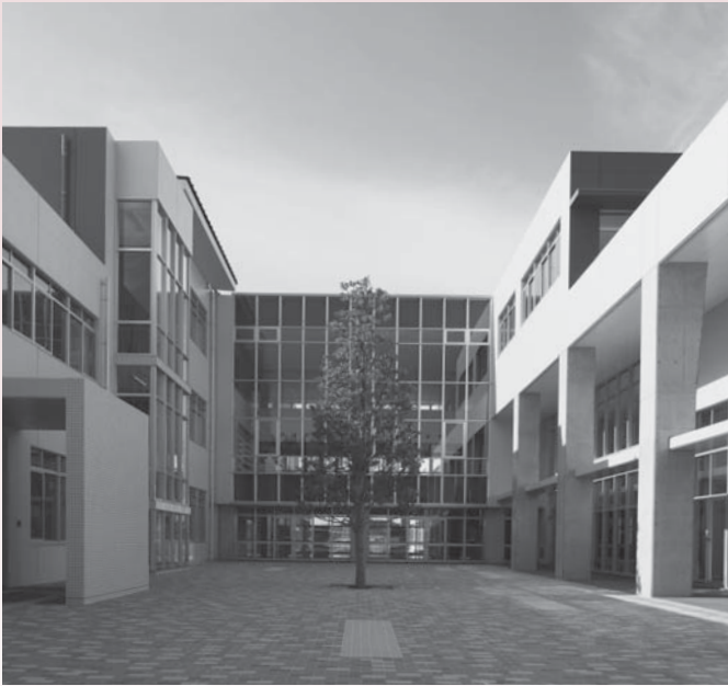
横芝中学校外壁漏水修繕工事
