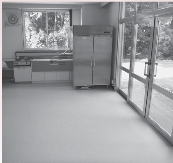
光小学校配膳室(床張替工事)
