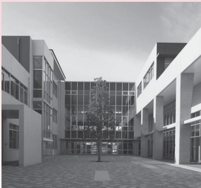
横芝中学校外壁漏水修繕工事
