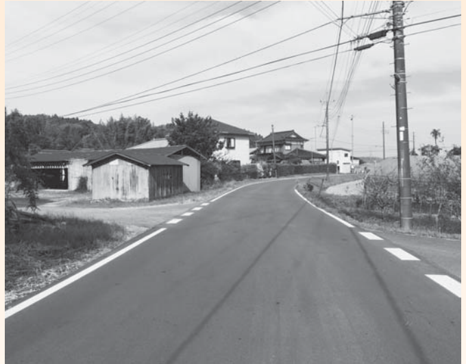
町道I-18号線外舗装修繕工事(新井地先外)
