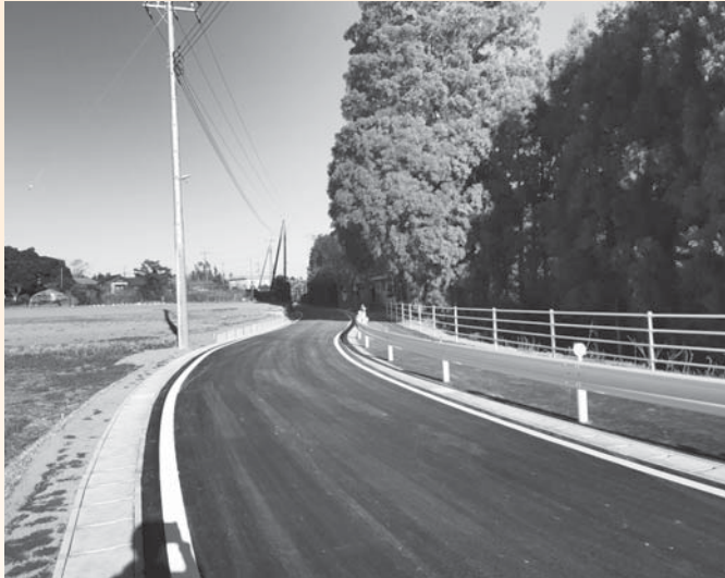
町道A122号線道路改良工事(木戸台地先)
