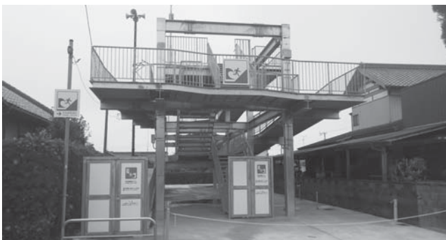
○津波避難タワー
