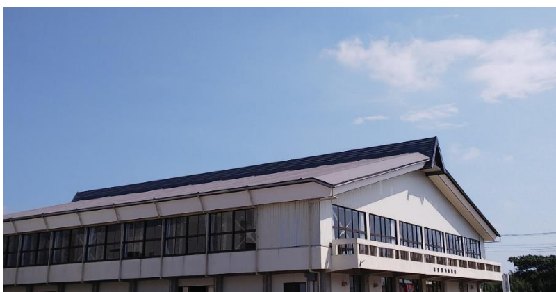
町体育館屋根改修工事（完成写真）
