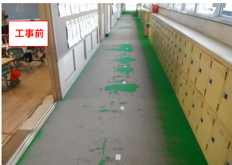
東陽小学校（現：光小学校）1階廊下床張替工事
