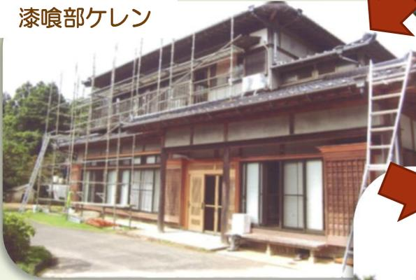
※「ケレン」とは塗装する箇所に付着したサビや汚れ、古い塗膜（塗り替え前の塗料で塗った部分）を落とす作業になります
