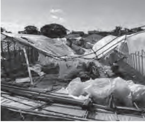
▶倒壊したビニールハウス
