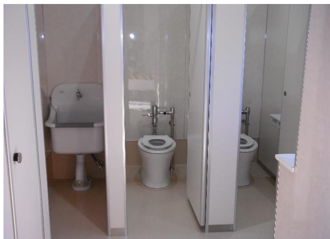
上堺小学校トイレ改修工事
