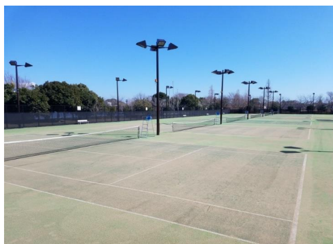
ふれあい坂田池公園テニスコート改修工事
