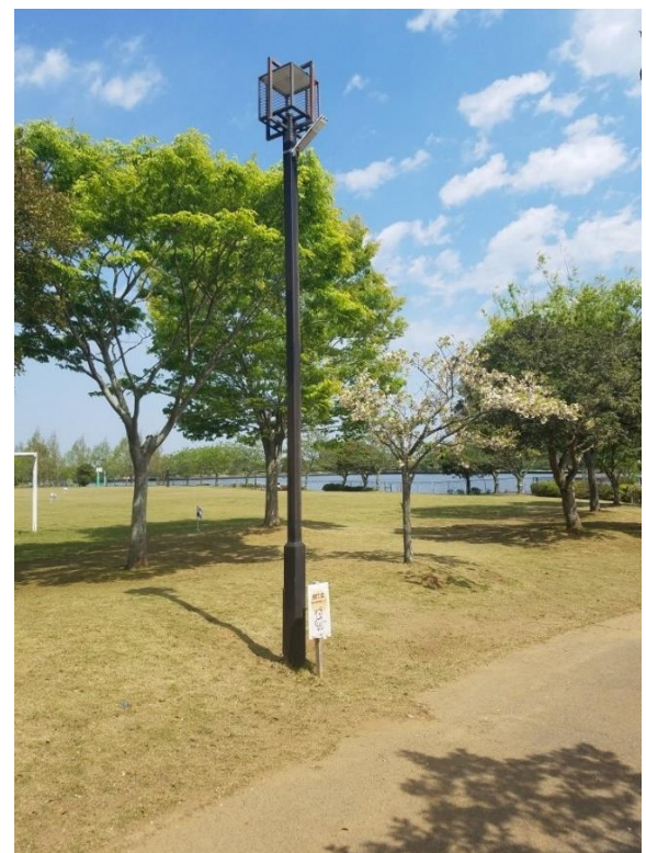
ふれあい坂田池公園外灯交換工事
