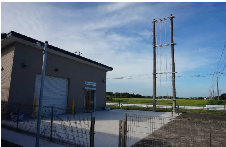
第1分団第2部ホース乾燥塔移設工事
