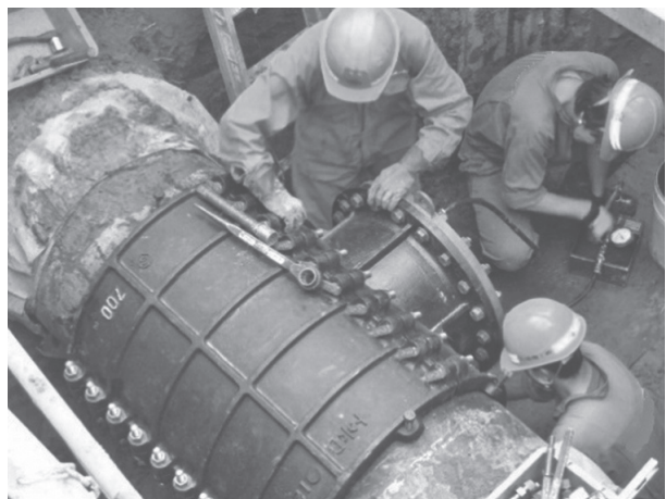
配水管敷設替
