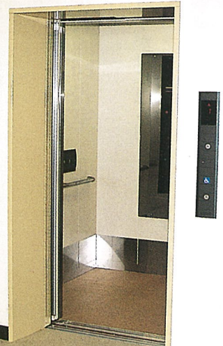
▲完成したエレベーター
