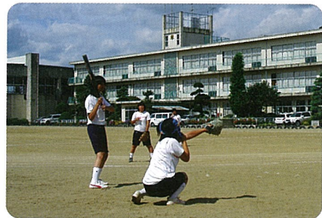
建設後43年が経過した横芝中学校
