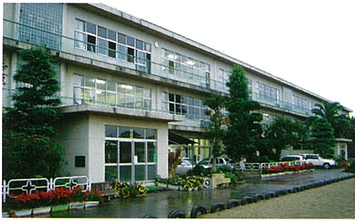
建て替えが望まれる横芝中学校校舎
