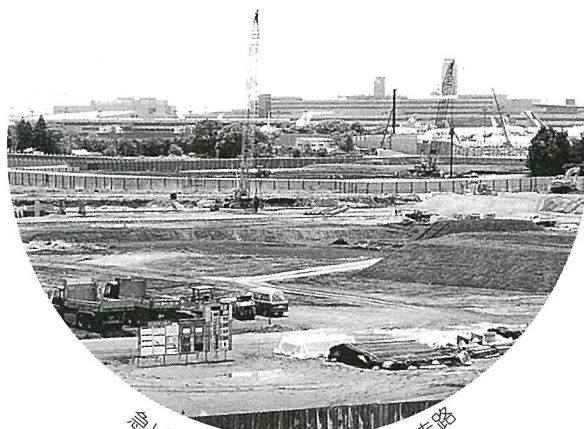
急ピッチで工事が進む平行滑走路
