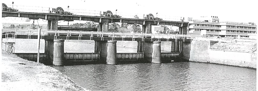
周辺住民の方々の利便性の向上と地域活性化を図るため 横芝塚付近に新たな橋梁が架る予定です
