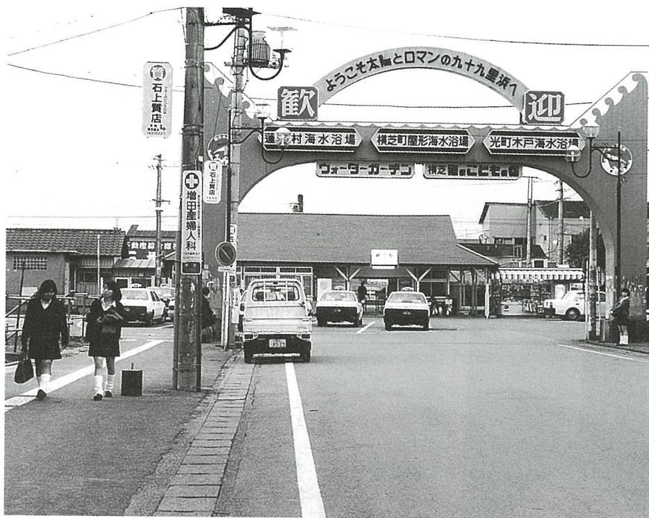
都市計画決定後に、改修が検討される予定の横芝駅舎と駅前広場
