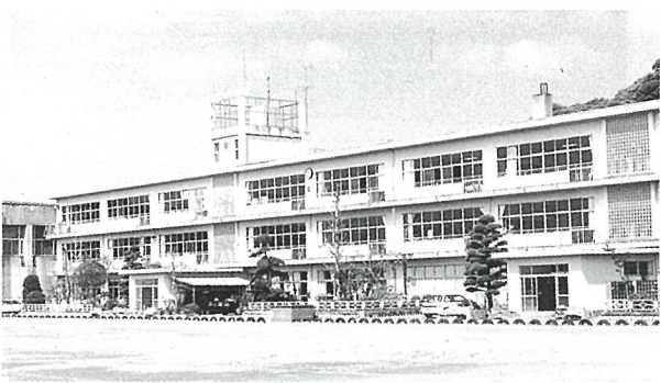
移転建築が計画されている横芝中学校
