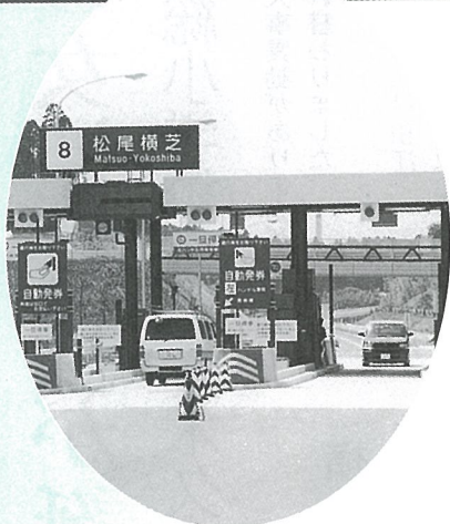
早期完成が待たれていた 千葉東金道路二期工事区間の開通式
