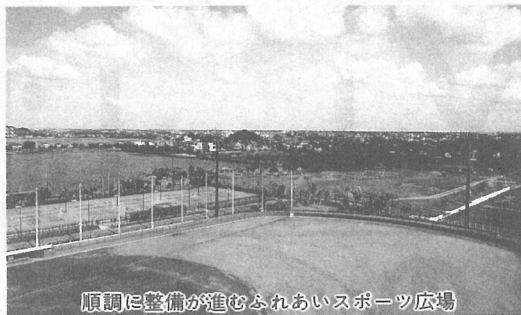
順調に整備が進むふれあいスポーツ広場
