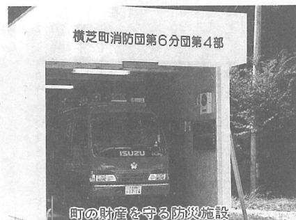
町の財産を守る防災施設
