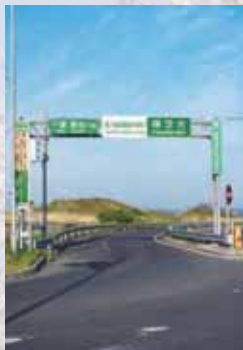
03 銚子連絡道路の横芝光インターチェンジ
