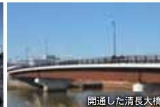
開通した清長大橋
