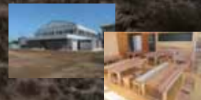
白浜小学校屋内運動場と特別教室が完成(平成25年)
