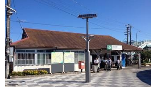
■ソーラー照明施設(1基)・案内板(2基)
