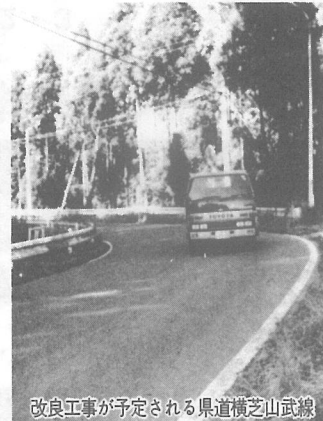
改良工事が予定される県道横芝山武線
