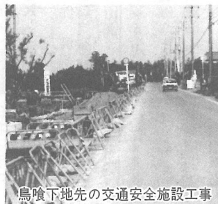
鳥喰下地先の交通安全施設工事
