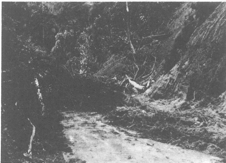
大総地区で発生した土砂くずれ
