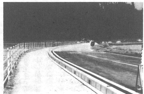
▶本年度の完成をめざして 工事のすすむ坂田・遠山線
