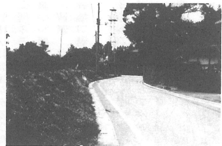
▶延長の予定される集落道 (木戸台)
