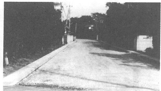
みなが見ている幹線道路の整備(町道新青東線)
