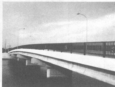
架け換えられた 新屋形橋 (5月19日 竣工)
