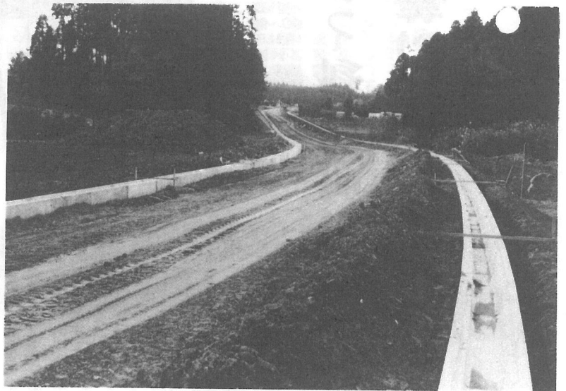
急ピッチで工事が進む大型町道坂田遠山線
