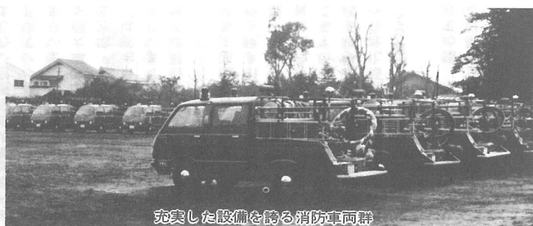
充実した設備を誇る消防車両群
