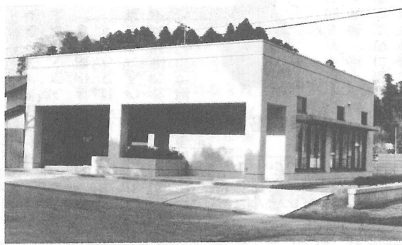
完成した長倉共同利用施設
