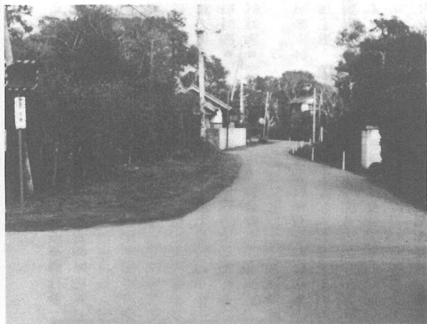
拡幅改良工事が待たれる新青・東線
